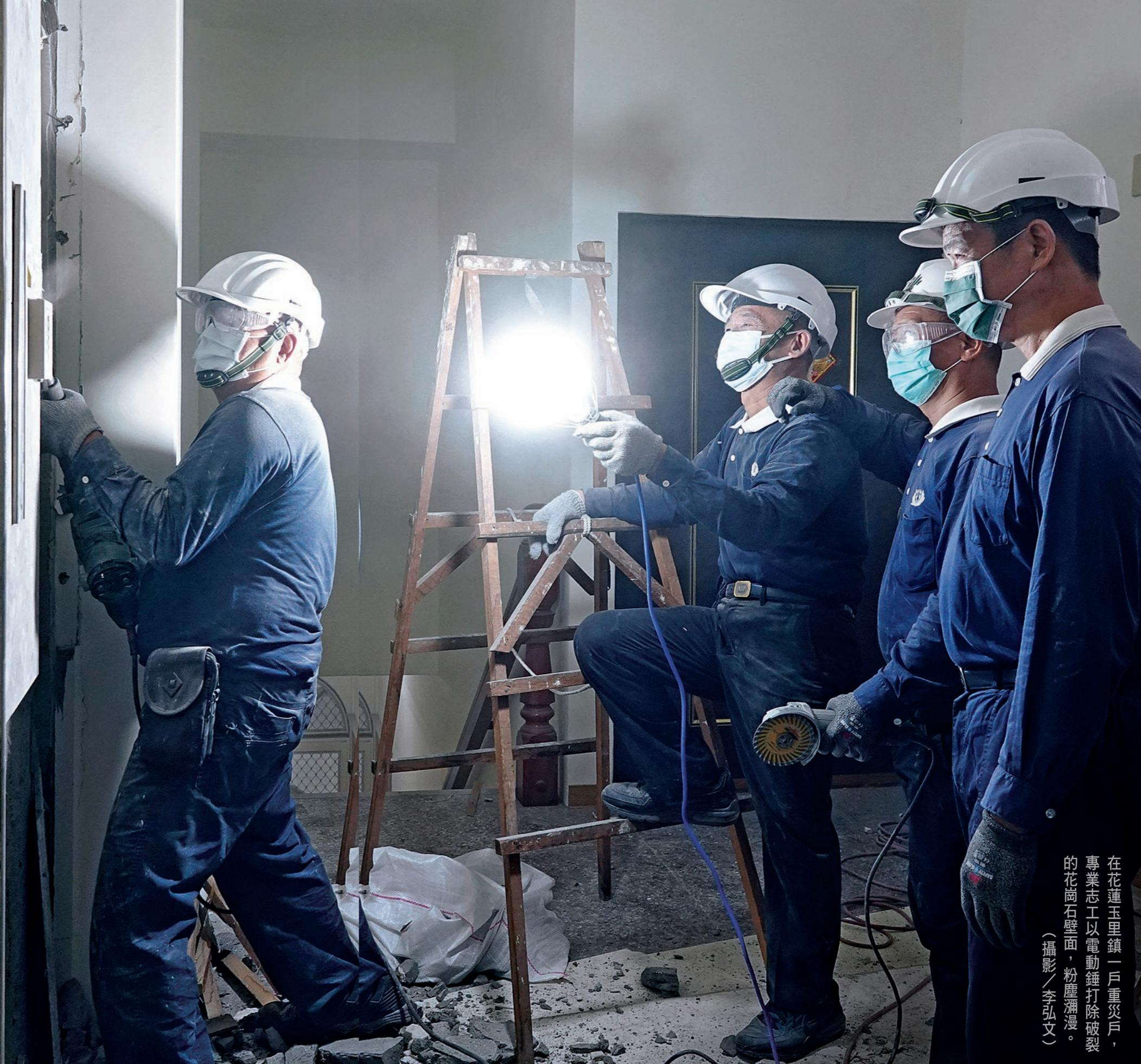
在花蓮玉里鎮一戶重災戶，專業志工以電動錘打除破裂的花崗石壁面，粉塵瀰漫。
