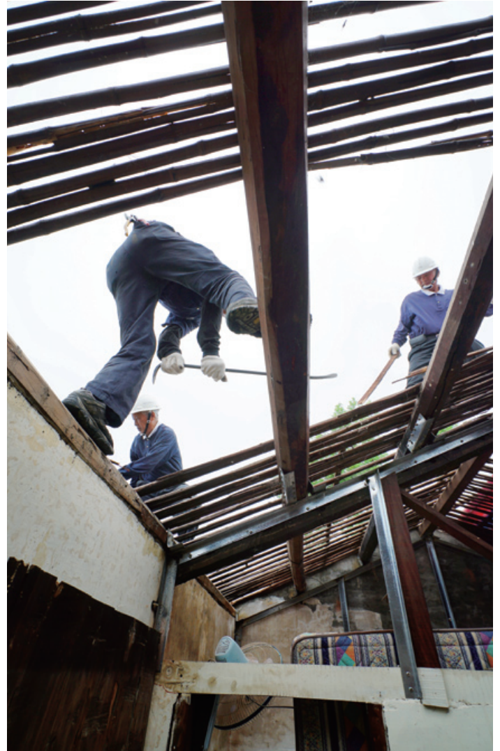
●屋根の上で腐った竹を取り除く陳龍泉、余滄波、劉文景。3人は暑い日も雨の日も休まずに仕事をし、被災者に早く安心して住める家を渡したいと思っている。
