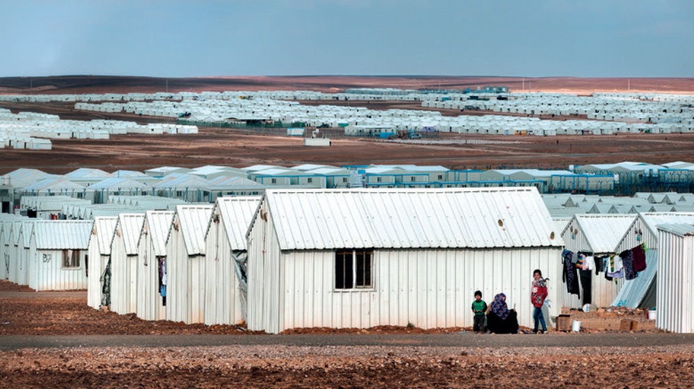
●延々と15キロも続くアズラク難民キャンプには仮設住宅を提供している区域があるが、物資も医療設備も欠乏しており、冬はとても寒く、難民の生活は困窮している。
