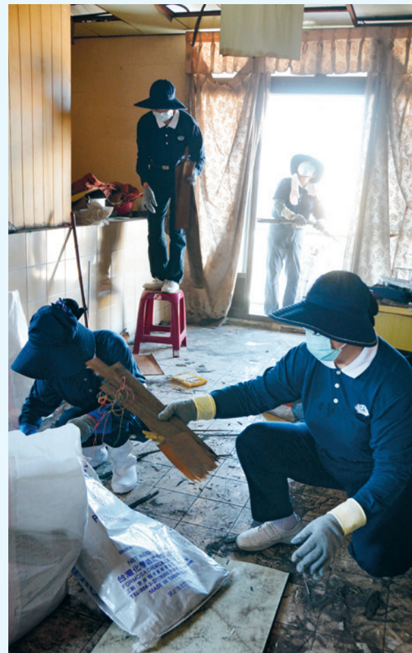
●物を置いている2階と3階の天井が落ちてしまったため、ボランティアが片付けている。 (撮影・施龍文)
