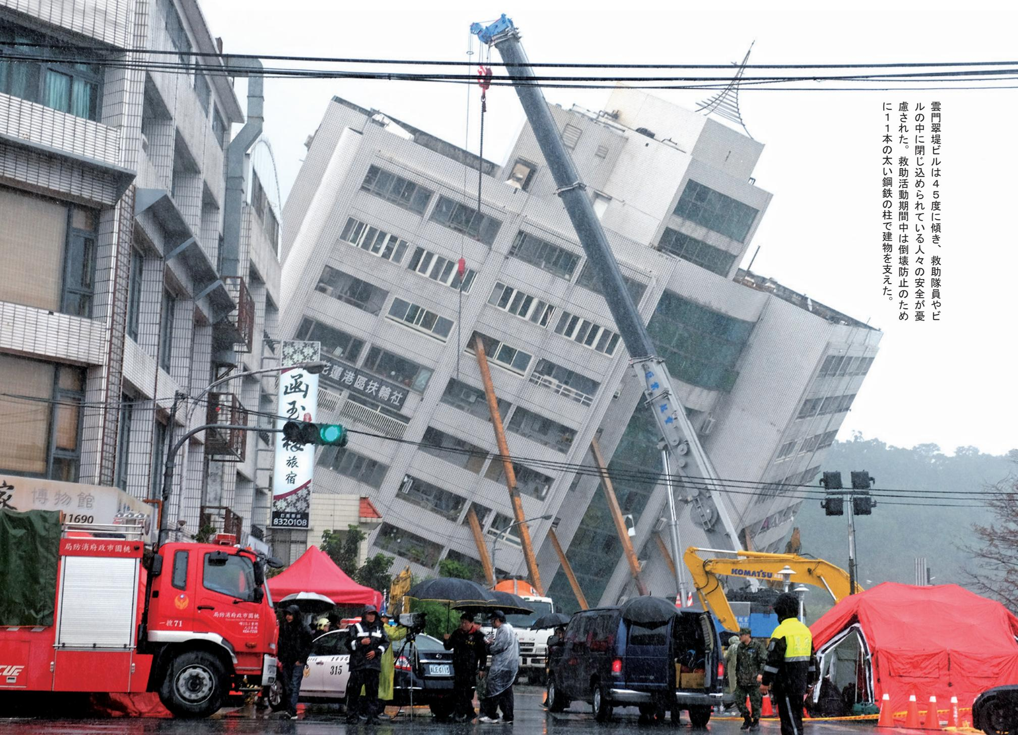
雲門翠堤ビルは45度に傾き、救助隊員やビルの中に閉じ込められている人々の安全が憂慮された。救助活動期間中は倒壊防止のために11本の太い鋼鉄の柱で建物を支えた。
