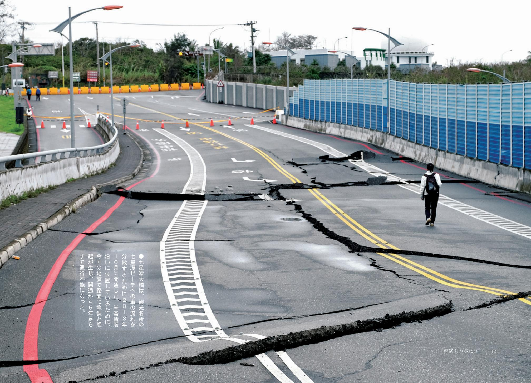
●七星潭大橋は、観光名所の七星潭ビーチへの車の流れを分散するために2013年10月に開通した。米蒂断層沿いに位置しているために、今回の地震で路面に亀裂と隆起が生じ、開通から5年足らずで通行不能になった。
