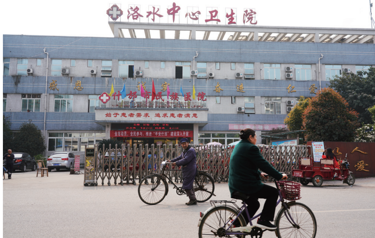
●洛水中学校はほぼ全壊し、犠牲となった生徒の家族にとって辛い思い出とならないようにとの配慮から、学校をほかの所に移した。今では洛水衛生センターになっている。
